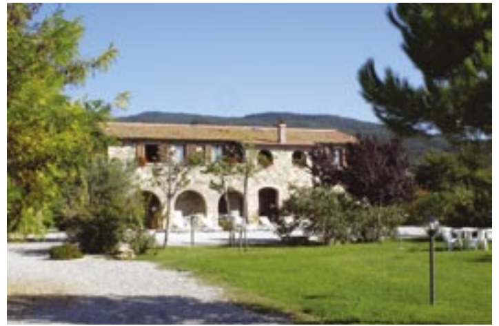
Im Podere Il Cicalino befinden sich die Wohnungen
